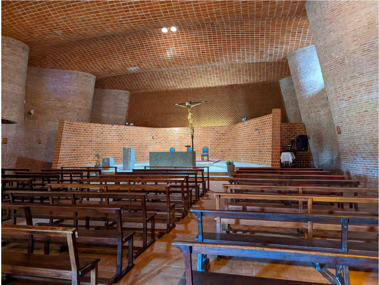
Fig. 16 Eladio Dieste, Skylight in Cristo Obrero, Cristo Obrero, Atlántida, Uruguay, 1953-60.
