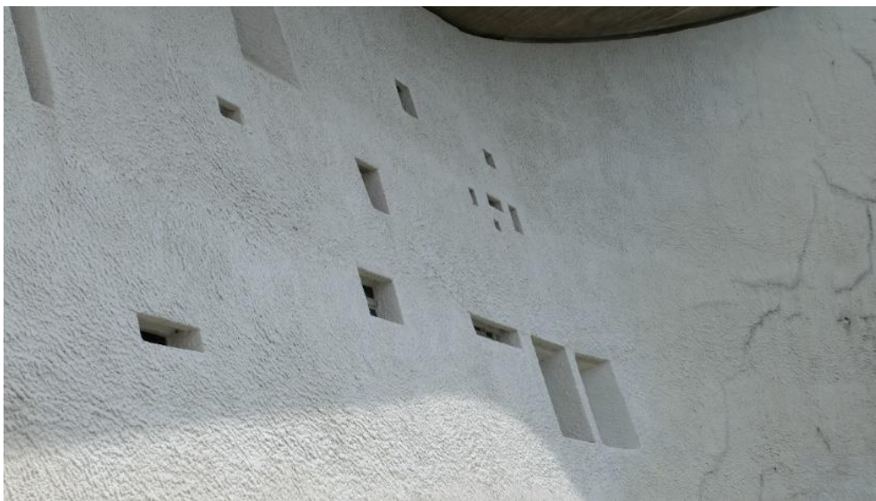
Fig. 7 Le Corbusier, south wall, Notre Dame du Haut, France, 1954
