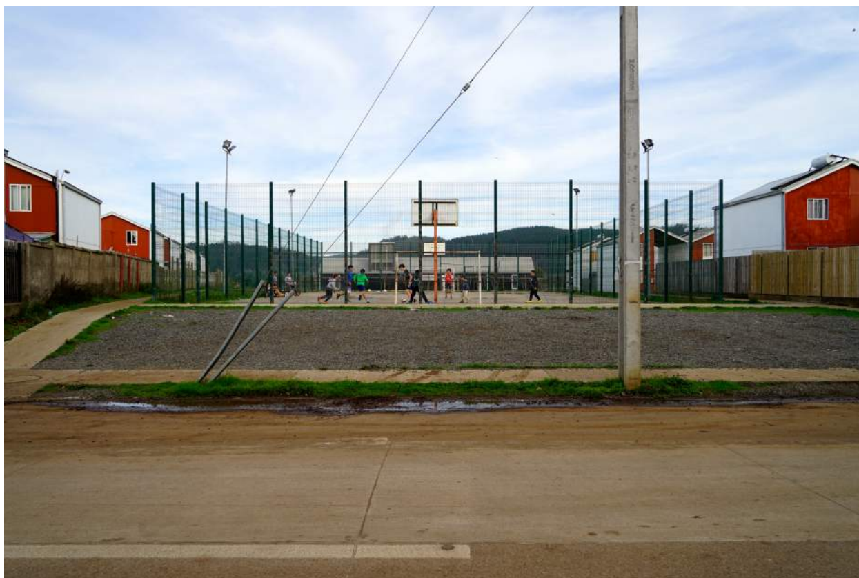
Fig. 13. ELEMENTAL, multipurpose court, Villa Verde, Constitución, Chile, 2010.
